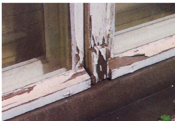
*Marcas de humidade e de bactérias numa janela de madeira de uma casa situada junto ao mar.*
